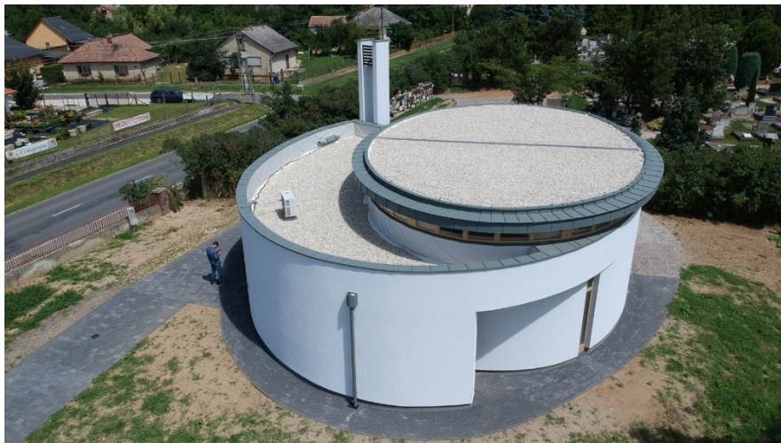
16:00 Balatonboglár Ravatalozó épület építész tervező: Pór Péter az „Év Balatoni Háza 2020” pályázat A NABE és a Magyar Építész Kamara különdíjazott
